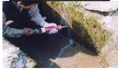
水路のひび割れ補修
