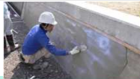
老朽化した水路壁のコーティング
