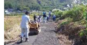
未舗装の農道をアスファルトで舗装
