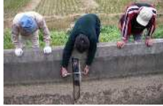
施設の機能診断
