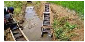
水田魚道の設置
