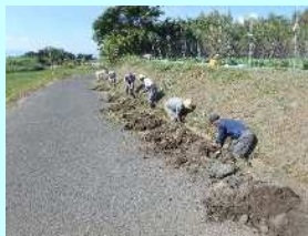
【水路土砂上げ】
